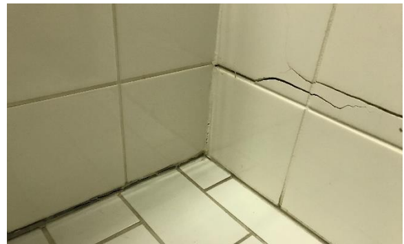
Kuva 25. Haljonneita seinälaattoja wc-tilassa
