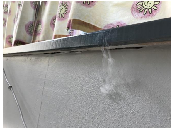
Kuva 23. Epätiivis ikkunaliittymä
