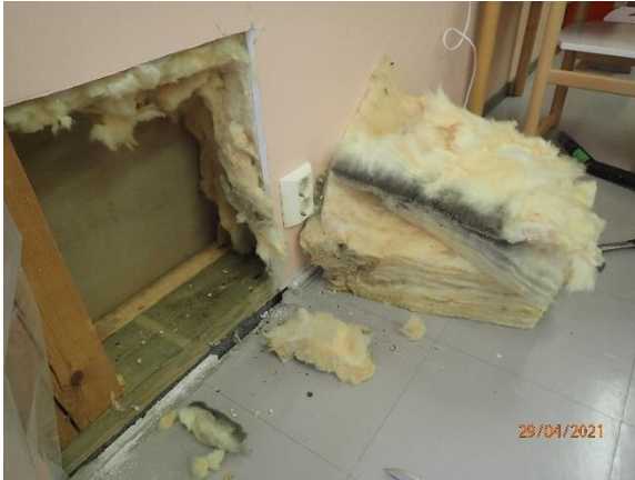
Kuva 14. Rakenneavaus 2, luokka itäsiivessä
