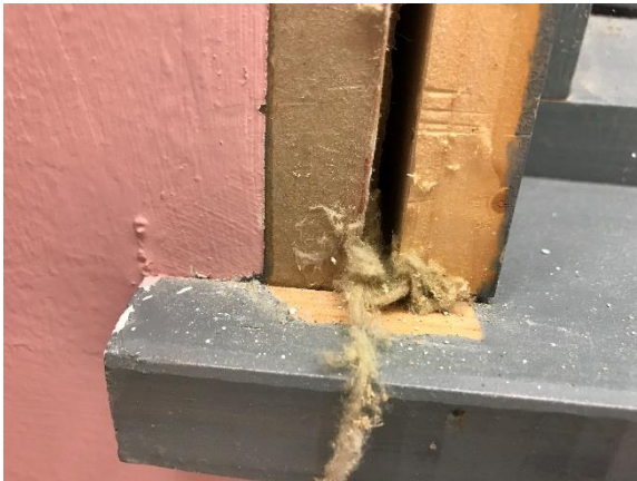
Kuva 20. Epätiivis ikkunaliittymä
