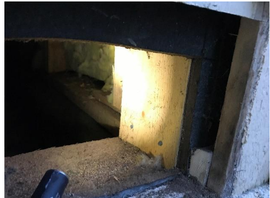
Kuva 21. Ulkoseinärakenne rakenneavauksen 7 kohdalla
