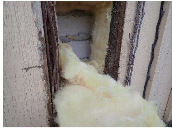
Kuva 25. Eristevilla on kiinni tiilipinnassa, rakenneavauskohta 8
