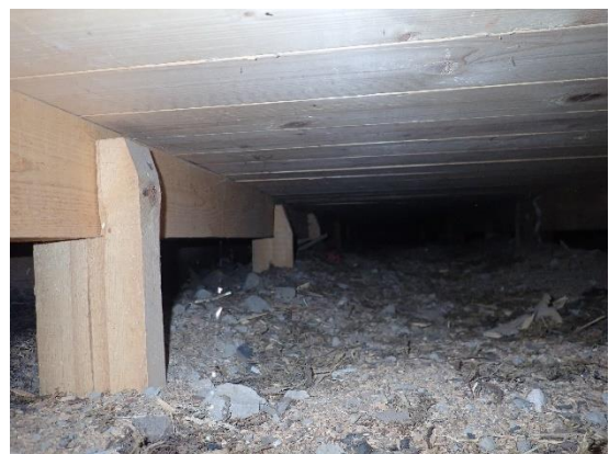
Kuva 3. Alapohjan puurakenteissa ei havaittu vaurioita, rakenneavus 3
