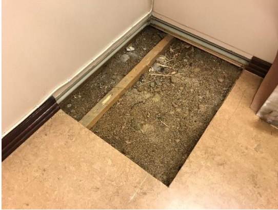
Kuva 16. Alapohjan päällimmäisenä kerroksena on noin 50 mm soraa ja kiviä, rakenneavaus 6
