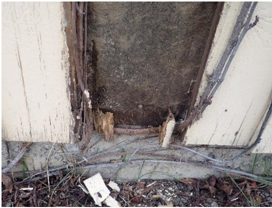
Kuva 24. Rakenneavauskohta 8 lisäsiiven ulkoseinässä
