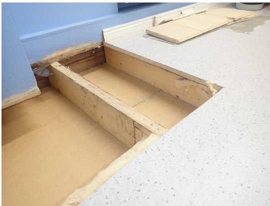
Kuva 12. Uusittu alapohjarakenne varastossa 114, rakenneavaus 5
