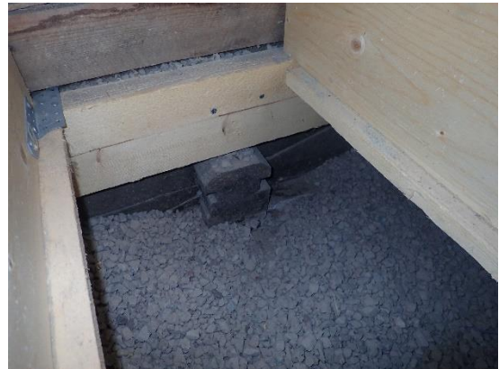
Kuva 15. Alapohjan alapuolinen tila on täytetty kapillaarikatkosepelillä, rakenneavaus 5
