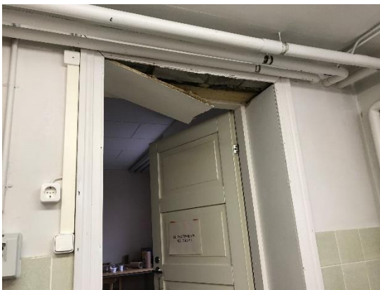
Kuva 26. Vanhan osan ja lisäsiiven liittymä pukuhuoneen 117 oviaukon kohdalla
