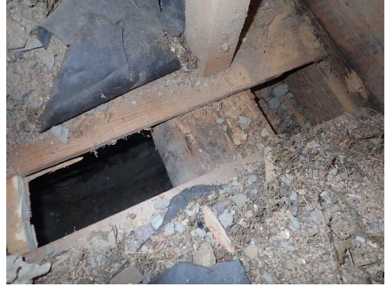
Kuva 17. Alapohjarakenteen alimpana kerroksen a on bitumipaperilla päällystetty pohjalaudoitus, rakenneavaus 6
