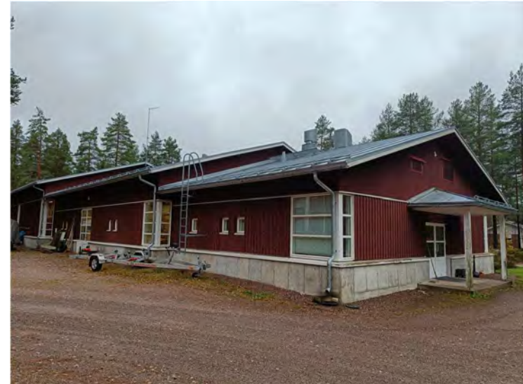
Kuva 66. Uuden venehallin julkisivuja.
