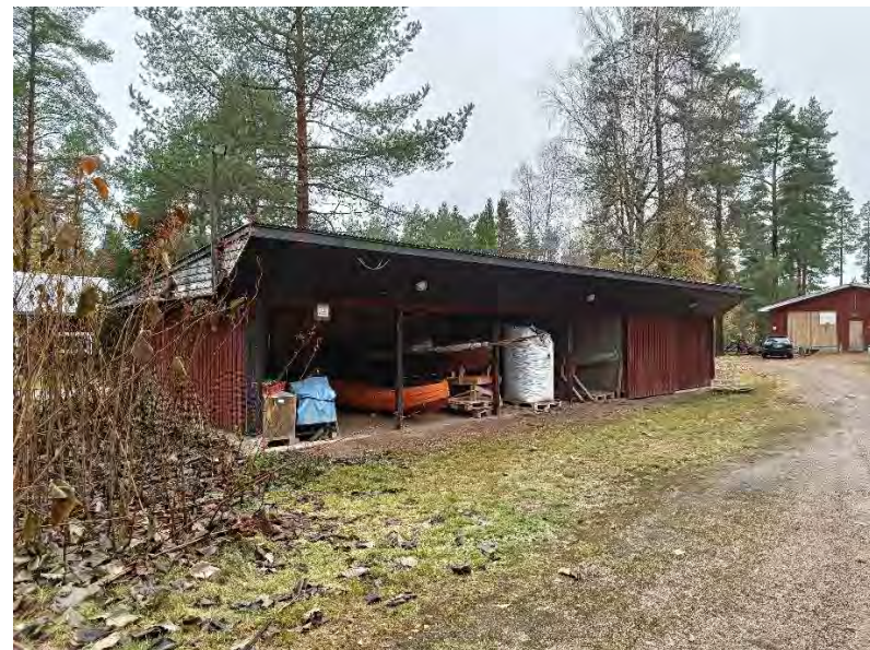
Kuva 74. Autokatos kuvattuna kaakosta.
