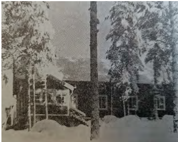
Kuva 4. Rehtorintalo eteläpuolelta kuvattuna.
