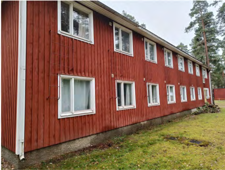
Kuva 46. Tyttöjen majoitustalon länsijulkisivu
