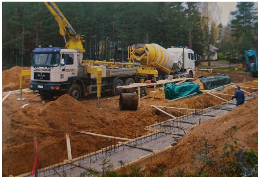
Kuva 63. Uuden venehallin anturoiden valua.
