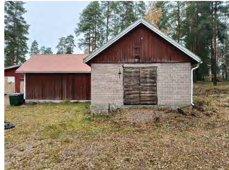
Kuva 36. Tinaverstaan eteläpääty. Vasemmalla puurakenteinen puuvarasto.
