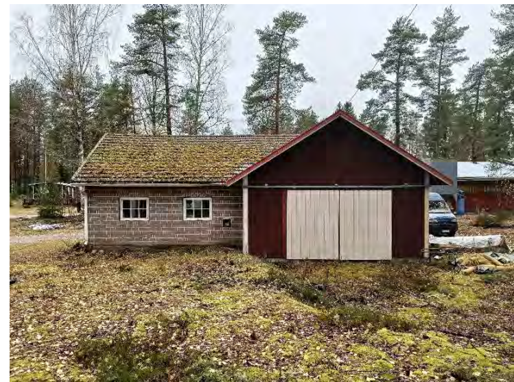
Kuva 37. Tinaverstaan itäjulkisivu, oikealla puuvaraston pääty.
