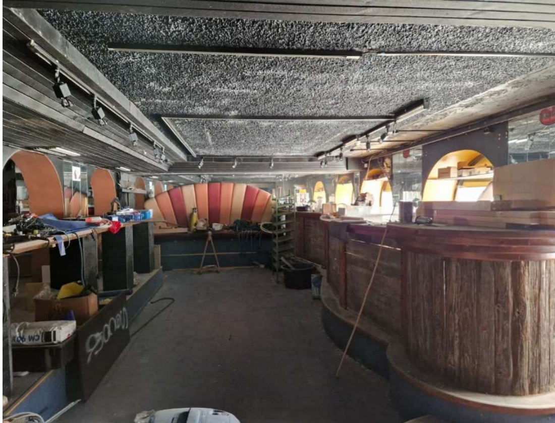
Kuva 37. Kellaritilan yökerho. Lattian alla on entinen uima-allas. Holvi-ikkunat on tehty julkisivuun jälkikäteen. Ensimmäisen altaan kohdalla oli tanssilattia, sittemmin baaritiski.
