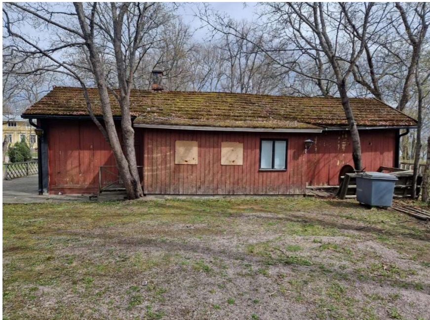
Kuva 52. Piharakennuksen julkisivu länteen.
