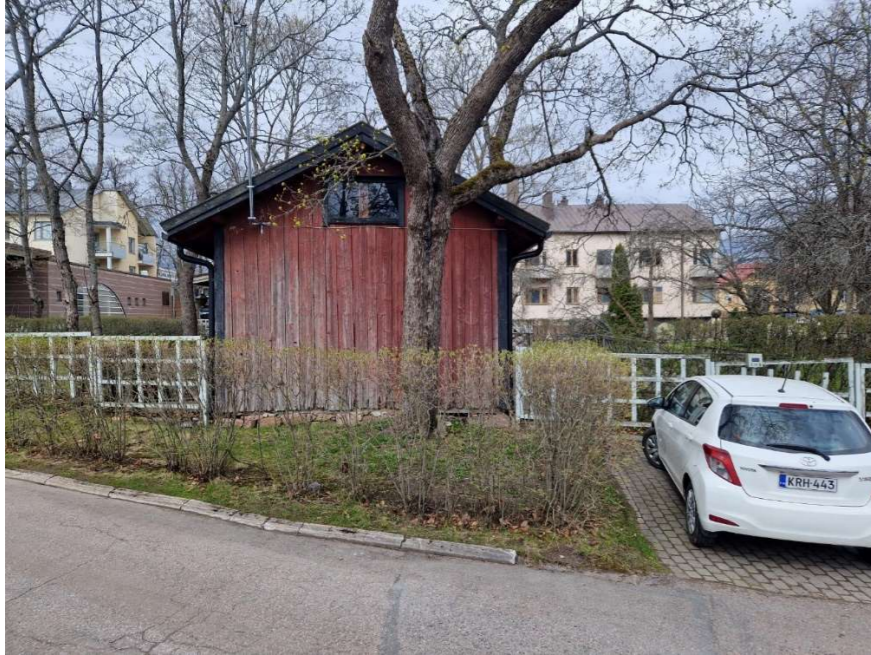
Kuva 51. Piharakennuksen julkisivu etelään.
