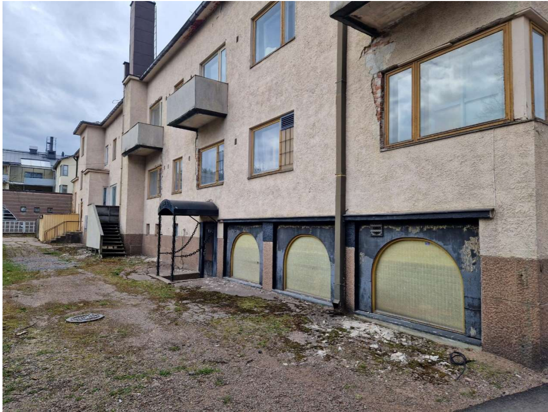
Kuva 29. Eteläjulkisivua länttä kohti. Kolmessa hotellihuoneessa on parveke, sen jälkeen julkisivusta erkanee kellarista nouseva piippu, sen toisella puolella vuonna 1991 tehty uusi oviyhteys pihalle. Sen takana porrashuone-erkkeri.
