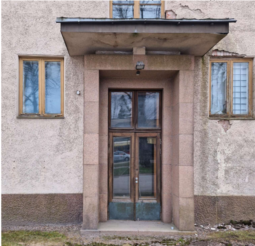
Kuva 26. Pohjoisjulkisivu itäisin ovi on alkuperäinen. Se on valmistettu tammesta samoin kuin sen yläpuolella olevat ikkunat.
