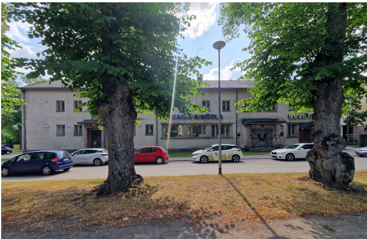
Tegelbyggnaden sett från Karlskronabulevarden. Byggnaden har ursprungligen varit hotell och senare haft restaurang- och nattklubsverksamheter.
