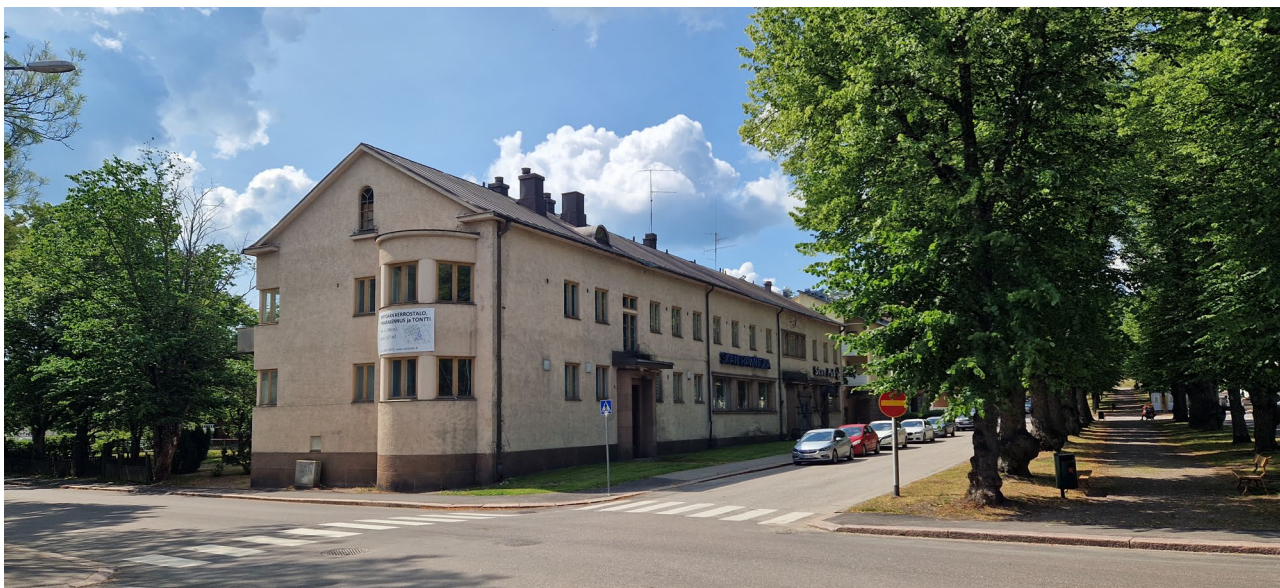
Tegelbyggnad i planeringsområdet. Från 1940-talet. Gränsar mot Karlskronabulevarden och Mariegatan.
