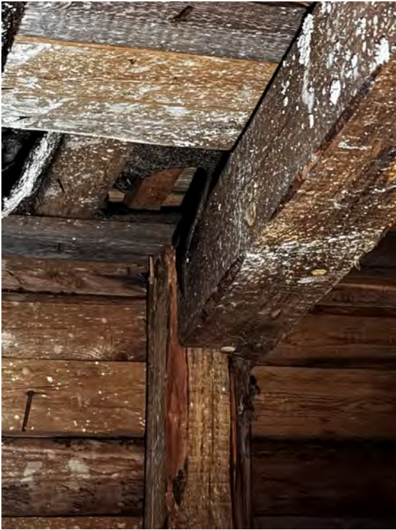
Kuva 28: Kosteusvaurioita puurakenteissa.
