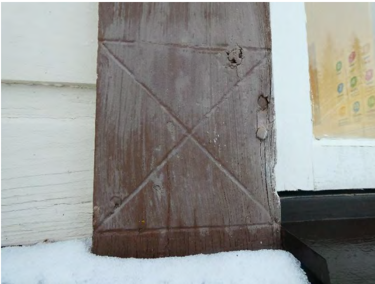
Kuva 16: Kuviointia ikkuna-aukon laudoituksessa.
