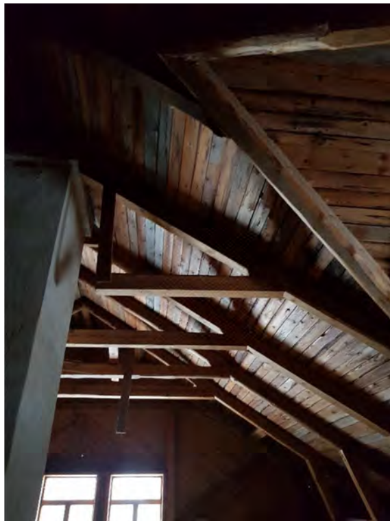
Kuva 27: Kattoristikon paarre oli katkaistu.
