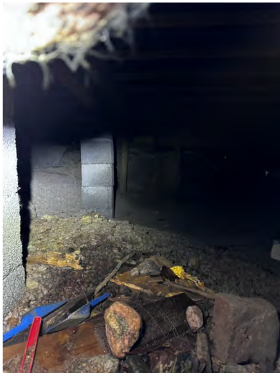
Kuva 11: Alapohjan harkkoperustuksia.
