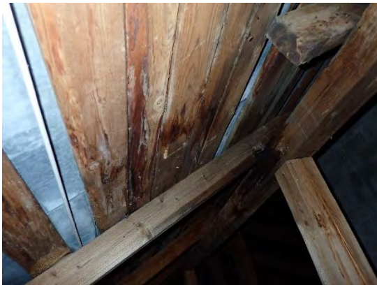
Kuva 37. Vuotojälki harjan läheisyydessä
