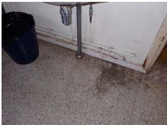
Kuva 11. Eteistilan alapohja, betonimosaikki pintalaatta
