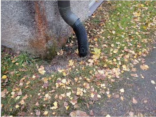
Kuva 45. Koulun tilojen puoleisella osalla sadevedet katolta betoniputkeen
