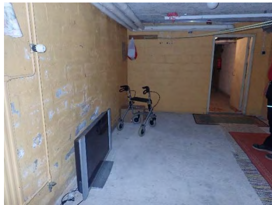
Kuva 10. Pinnoittamaton kellarin alapoha
