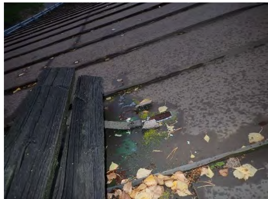
Kuva 30. Vanhan kattosillan rakenteita, kiinnitysraudat poikki, kiinnikkeen reikä auki vesikatteessa
