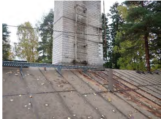
Kuva 28. Yleisnäkömä keittiö/asunto osan vesikatolle
