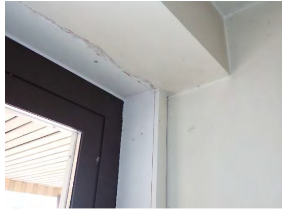
Kuva 19. Ovi liittymä seinärakenteeseen
