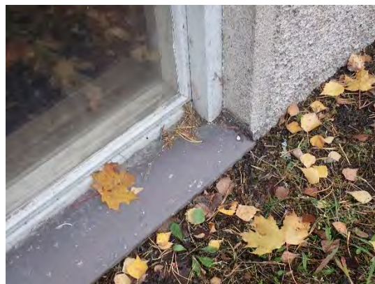
Kuva 17. Kellarin ikkunan liittymä perusmuuriin, lähellä maanpintaa
