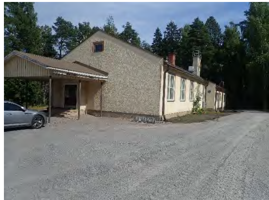
Kuva 42. Liikennealue ylärinteen puolella, pintavedet virtaavat rakennusta vasten.
