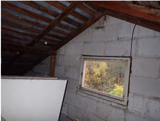
Kuva 13. Ulkoseinärakennne on ullakolla näkyvissä
