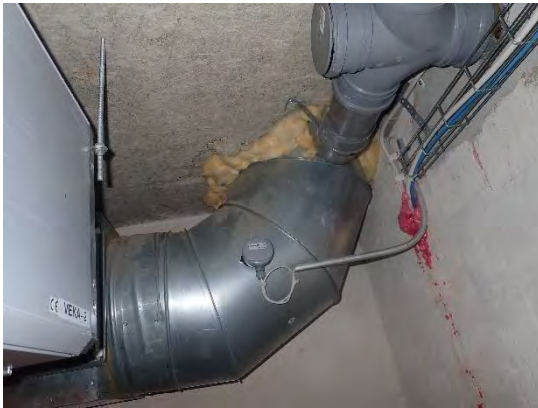
Kuva 23. IV kanava läpivienti välipohjasta, villa tilke tiivistyksenä
