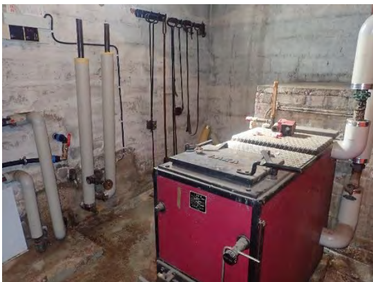
Kuva 5. Lämpökeskustila, kosteusjälkiä
