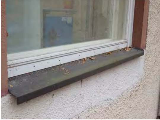
Kuva 20. Uuden ikkunan liittymä seinärakenteeseen
