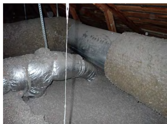
Kuva 36. Yleisnäkymä keittiön YP tilaan
