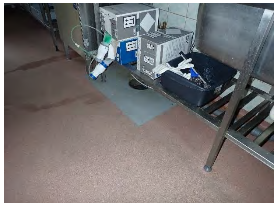
Kuva 26. Keittiön lattiaa korjattu
