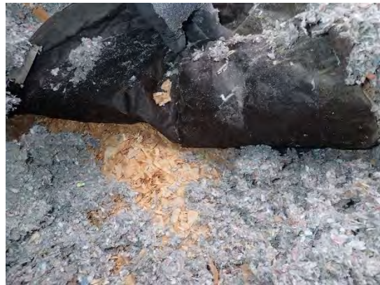
Kuva 38. Puhalluseristeen ja kutterilasteristeen välissä on bitumipaperi
