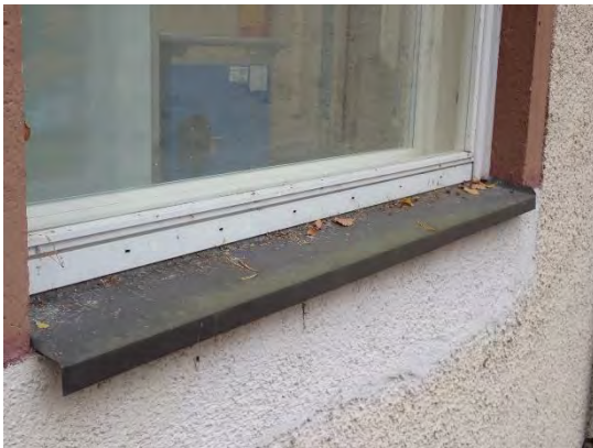
Kuva 15. Ikkuna madallettu keittiön osalla
