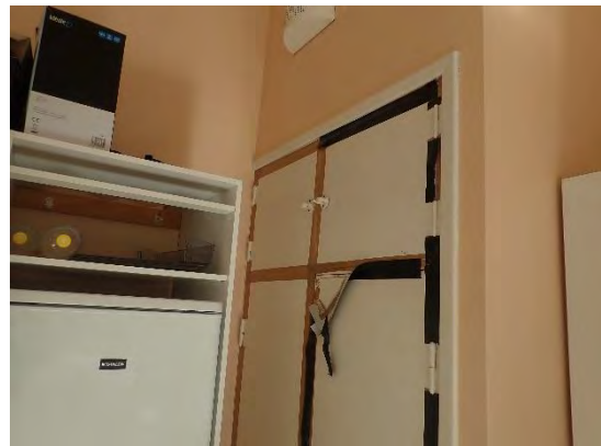
Kuva 24. IV pystykuiluna toimiva komeroryhmä vanhan keittiön nurkassa
