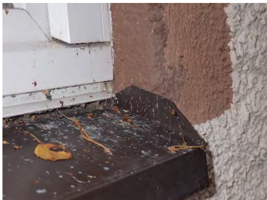
Kuva 16. Uuden ikkunan vesipeltiliitos
