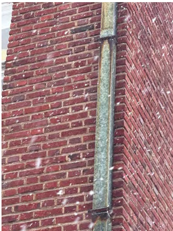
Kuva 6: Vaurioitunut syöksytorvi.
