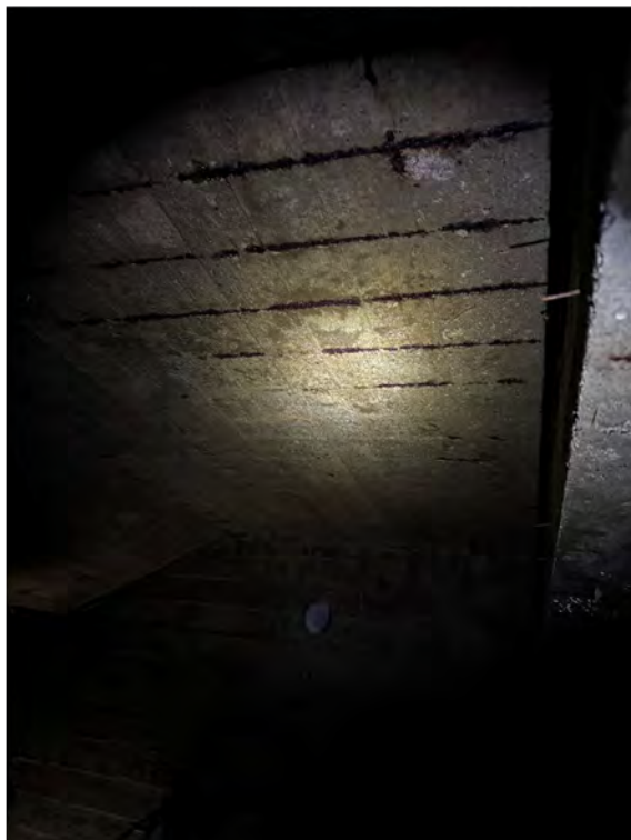
Kuva 11: Välipohjalaatan raudoitusvaurioita.
