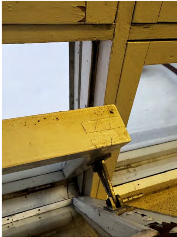
Kuva 30: Ikkunoiden tiivistyksissä ei havaittu merkittäviä puutteita.
