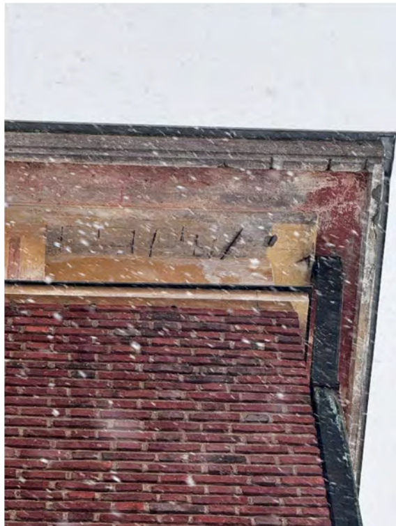
Kuva 23: Räystääslistan vaurioita.
