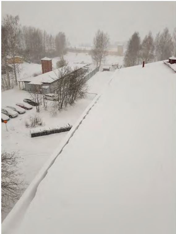
Kuva 35: Lumiesteiden määrä oli puutteellinen.
