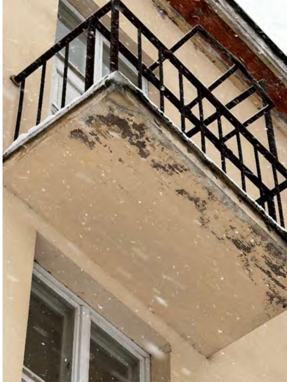
Kuva 21: Parvekelaatan vaurioita.
