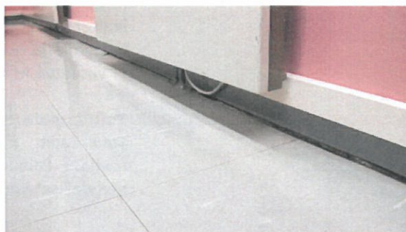
Kuva 2.11.4 ja 2.11.5 Lattian painumisen johdosta seinä sauma on paikoin auki.
