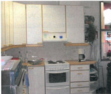
Kuva 3.8.1. Keittiön astianpesukoneelle ei ole huuvausta, josta aiheutuu kosteuskuormaa .
