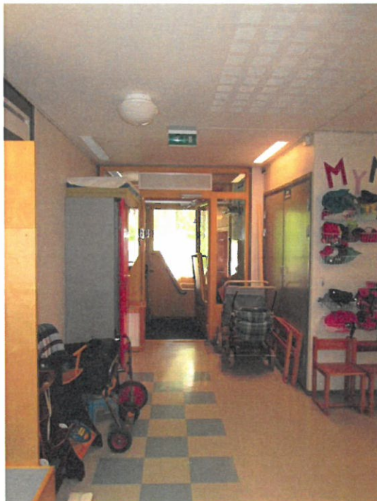
Kuva 4.11.3. Poistumistieopasteet eivät palaneet.
