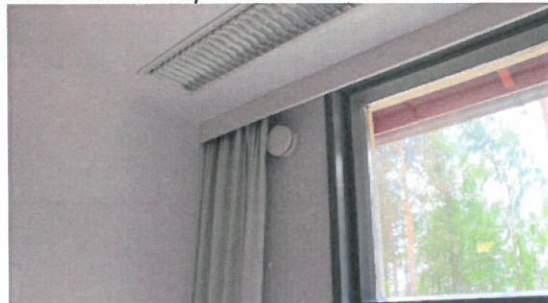
Kuva 3.8.5. Raitisilma tuodaan ulkoseinien raitisilmaventtiilien kautta huoneisiin.
