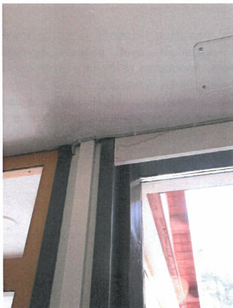
Kuva 2.11.1. Sisäänkäynnin vieressä katossa on kosteusjälki. Kuva 2.11.2. Varasto huoneen katossa on kosteusjälki. Molemmille ehdotetaan tarkempaa kosteuskartotusta.
