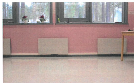
Kuva 2.11.4 ja 2.11.5 Lattian painumisen johdosta seinä sauma on paikoin auki.
