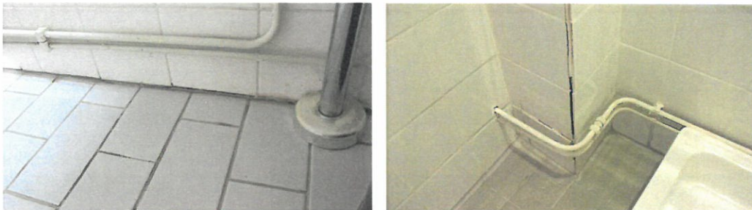
Kuva 2.11.6 ja 2.11.7 Märkätilojen laattasaumoja on murtunut.
