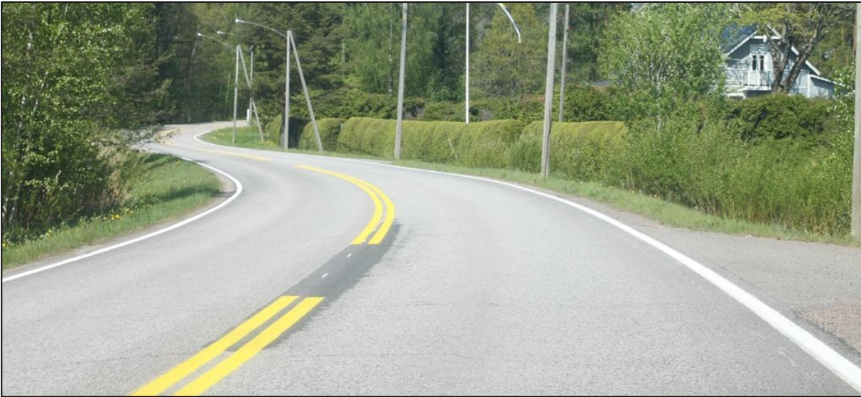
Bild 5.3.1-1. Skärgårdsvägen skärs av vid Märlox vid en havsöversvämning på 1/100a (N2000 +2,22). (Bild: FCG Suunnittelu ja tekniikka Oy den 23.5.2014).
