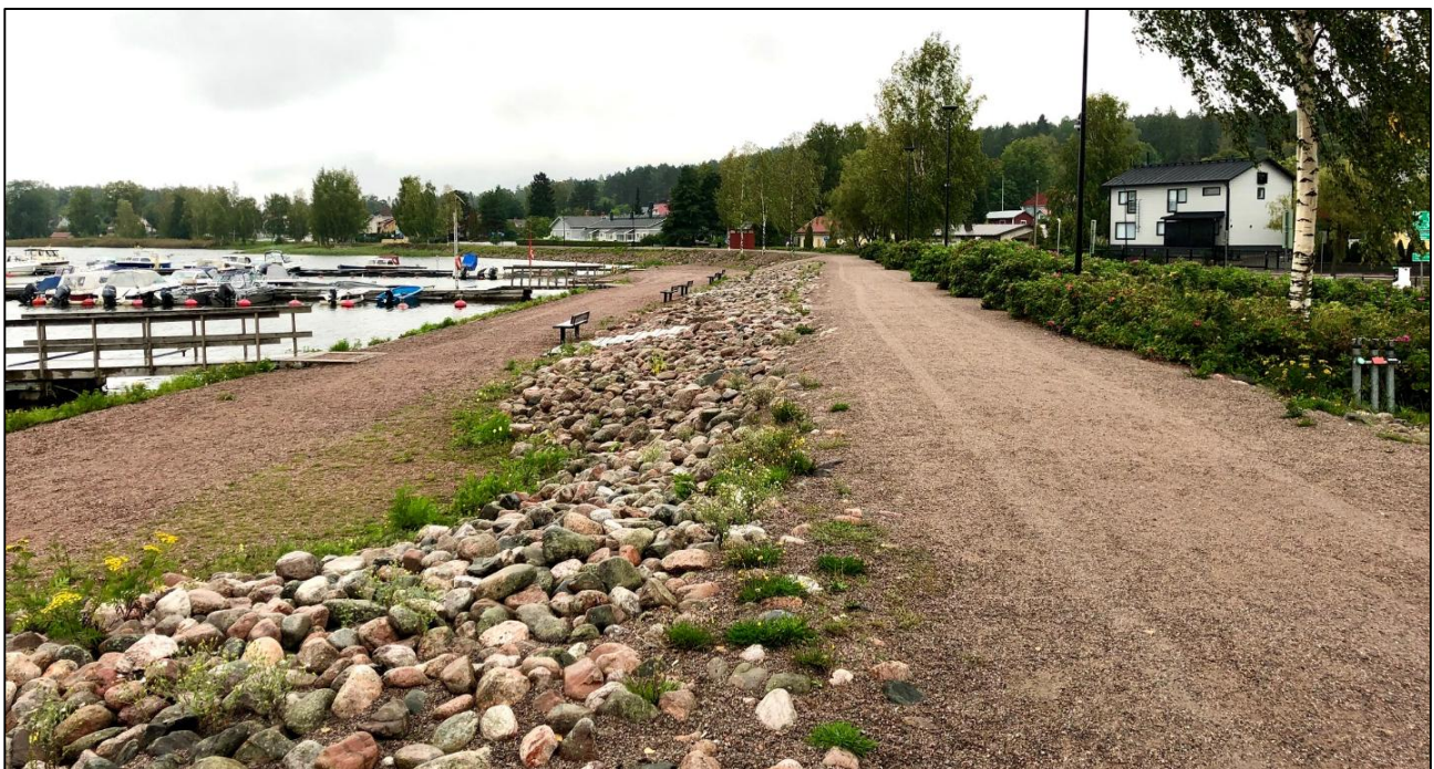
Bild 2.3-1. Skyddsvall i Lovisa centrum, utsikt från Skeppsbron söderut 9.9.2019
