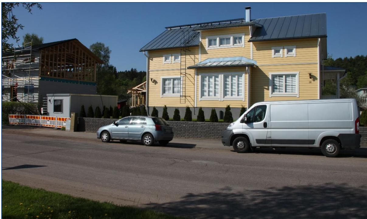
Bild 5.1.1-1. Nya bostadsbyggnader samt bostadsbyggnader som är under konstruktion vid Strandvägen bakom skyddsvallen i Lovisa centrum. I de nya byggnaderna har lägsta rekommenderade grundläggningsnivåer tagits i beaktande. Detta kan ses på socklarnas höjd. (Bild: FCG Suunnittelu ja tekniikka Oy den 23.5.2014)
