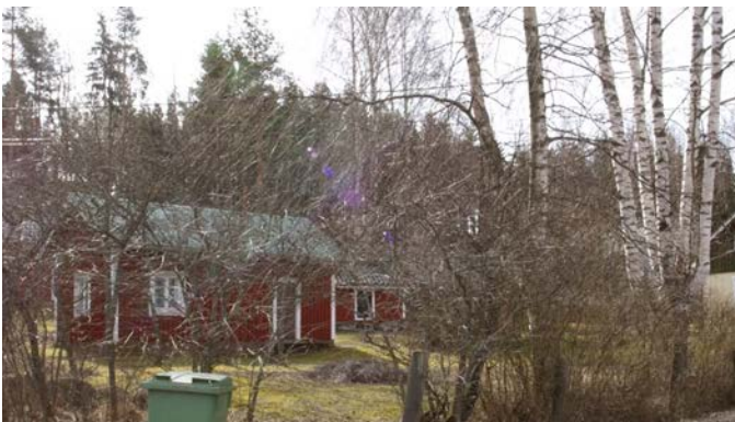
28. punainen pihamökki(1908) ja sen vieressä toinen pieni mökki (ei näy kuvassa) ovat suojeltu asemakaavassa: A-luokka. Tontin mineriittivuorattu asuinrakennus (1920) B-luokka.
