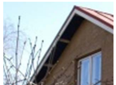
5. 1950-l. Aikakaudella maalattiin ikkunakarmi usein erivärisiksi kuin vaalea puite. Myös räystäänaluslaudoitus maalattiin usein eri värillä kuin seinät ja kattotuolien päät.
