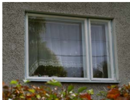
5. 1950-l. Aikakaudella maalattiin ikkunakarmi usein erivärisiksi kuin vaalea puite. Myös räystäänaluslaudoitus maalattiin usein eri värillä kuin seinät ja kattotuolien päät.
