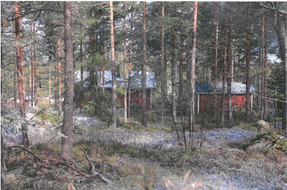
Kuva 4 Laajennettavan huvilan viereinen rakennus ?
