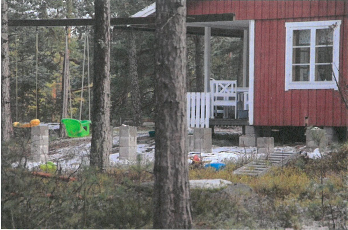
Kuva 3 Työ käynnistetty luvatta.
