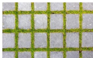
Exempel på dagvattenlösningar och gräsarmering.
