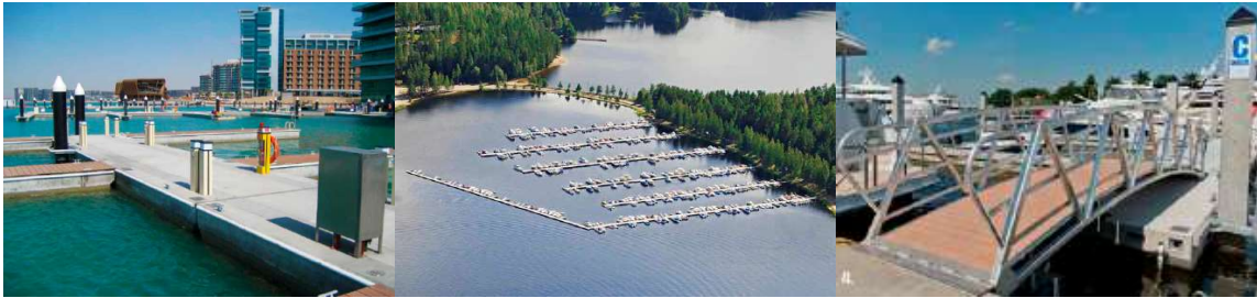
Bild 39,40,41. Bilder på hamnkonstruktioner och New Port Imatra, Marinetek Finland.
