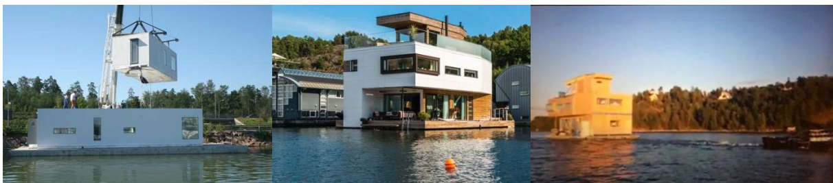
Bild 32, 33, 34. Referensbilder om installering av ett flytande hus, färdigt hus i Sverige och bogsering av ett flytande hus (Bluet Oy).
