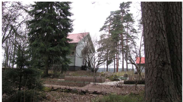
Byggnad 2. Byggnaden har blivit färdig kring 1940-talet.
