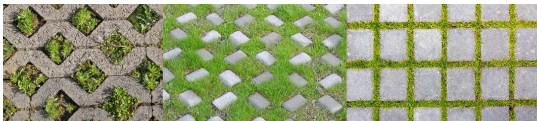
Exempel på gräsarmering.
