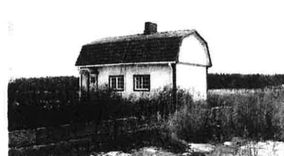
Sauna- ja talousrakennus. Etualalla rakennettua rantapengertä
