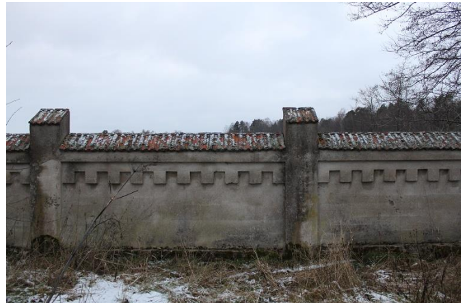
Muren kring fastigheten.
