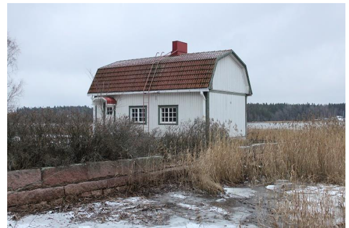
Bastu- och ekonomibygnad. I förgrunden byggd strandterrass.
