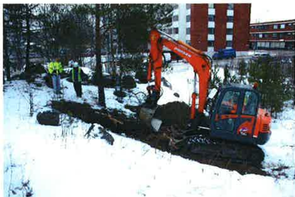
AKDG5145:4 Den nord-sydliga delen av provdiket grävs. Från väster. Foto Katja Vuoristo.
