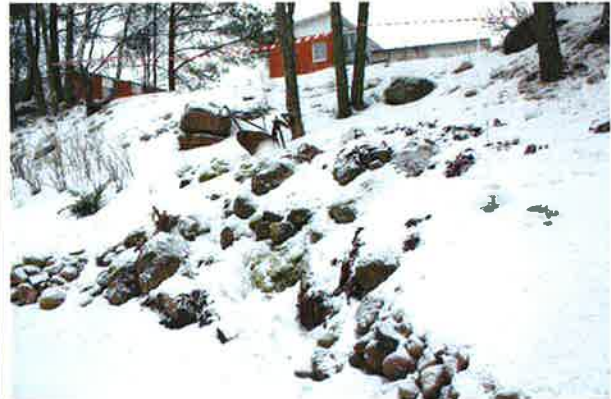
AKDG5145:21 Sannolikt ursprunglig stödmur i vallens sydöstra sida. Från nordväst. Foto Katja Vuoristo.
