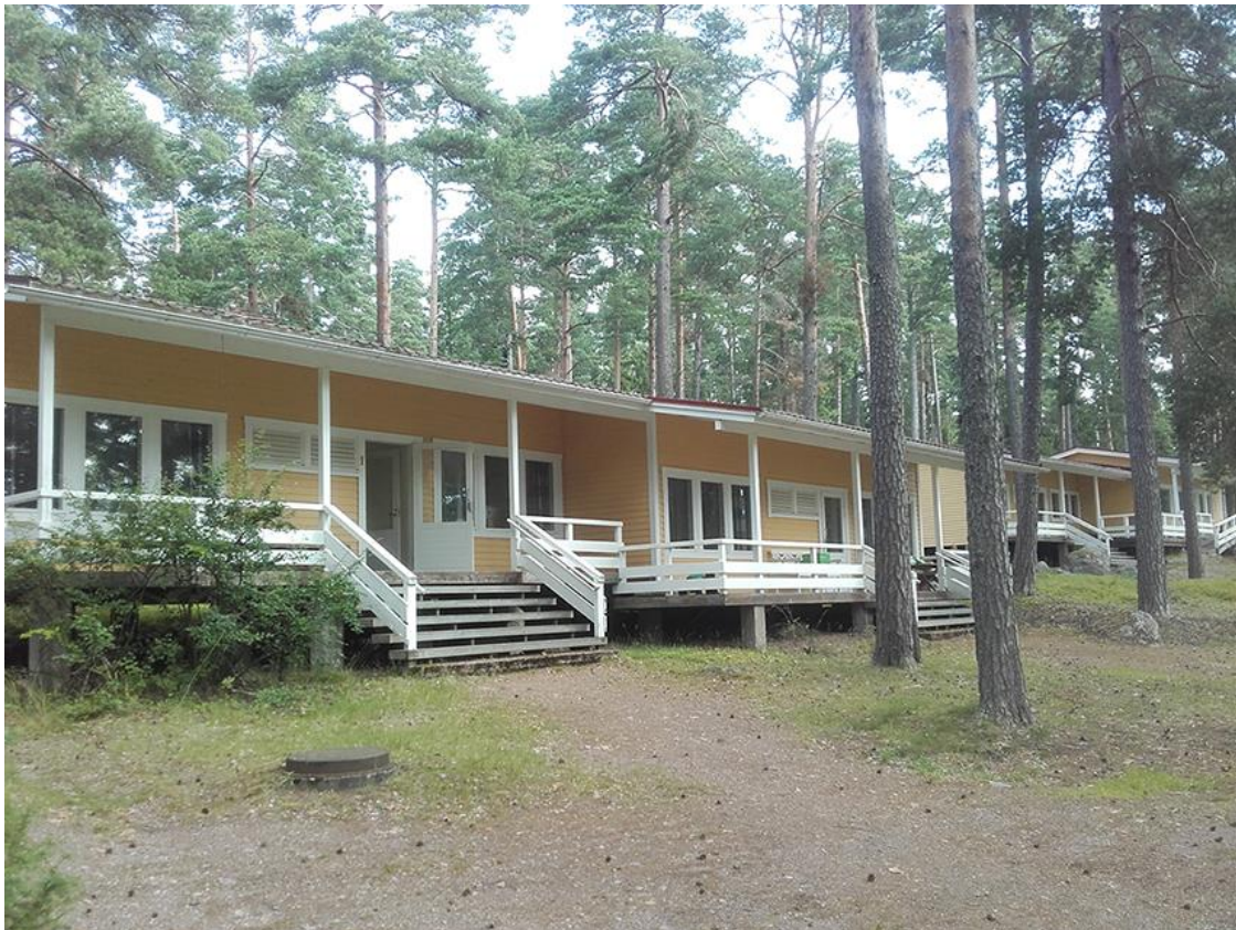
Bild 5. Inkvarteringsbyggnaderna som kommer att rivas.
