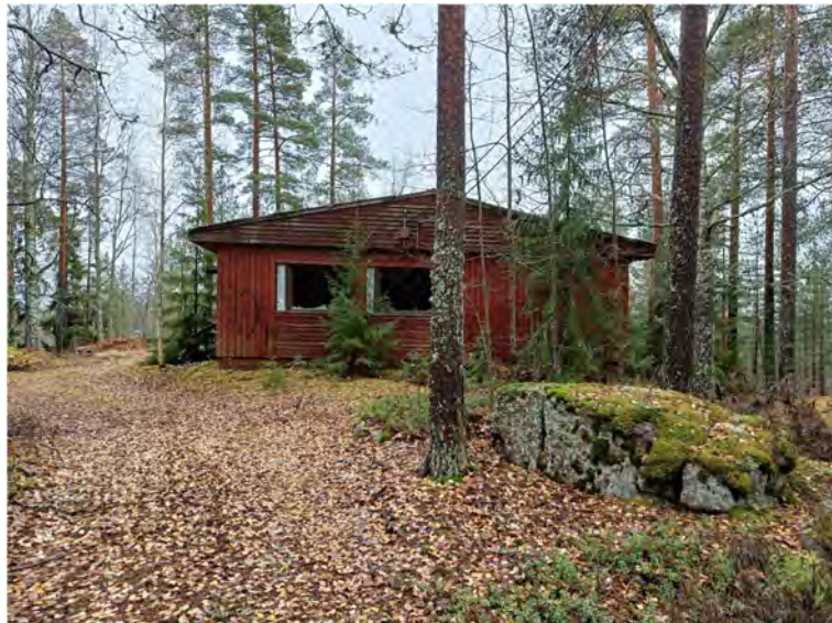
Kuva 50. Opettajien asuntolan pohjoisjulkisivua.
