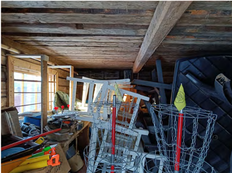
Kuva 25. Sisäkuva aitan ensimmäisestä kerroksesta.
