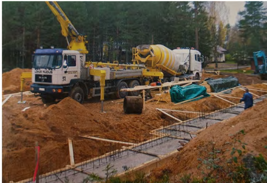
Kuva 63. Uuden venehallin anturoiden valua.
