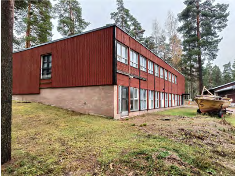
Kuva 52. Poikien asuntola pohjoisesta kuvattuna.
