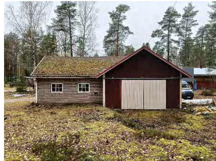
Kuva 37. Tinaverstaan itäjulkisivu, oikealla puuvaraston pääty.
