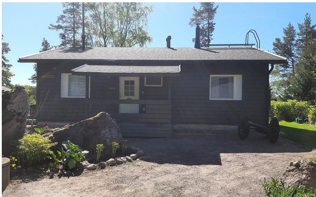
Kuva 13. Loma-asunnon julkisivu pohjoiseen.
