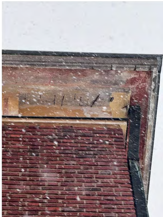
Kuva 23: Räystääslistan vaurioita.
