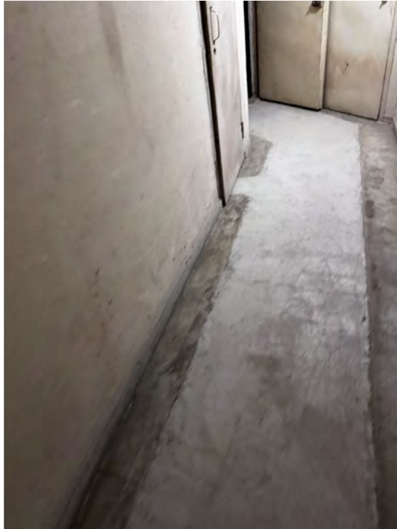
Kuva 13: Yleiskuva kellarin lattiasta.
