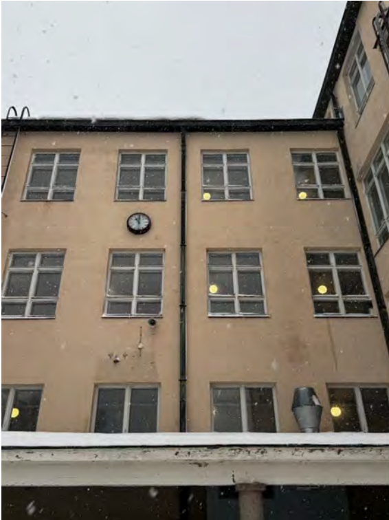
Kuva 14: Yleiskuva sisäänkäynnin julkisivusta.
