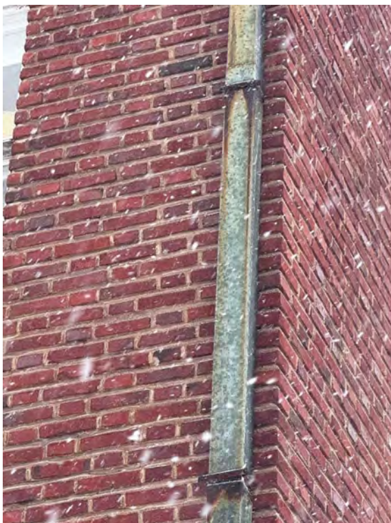
Kuva 6: Vaurioitunut syöksytorvi.
