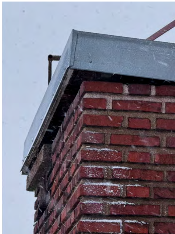
Kuva 34: Irronnut räystäsrakenne.
