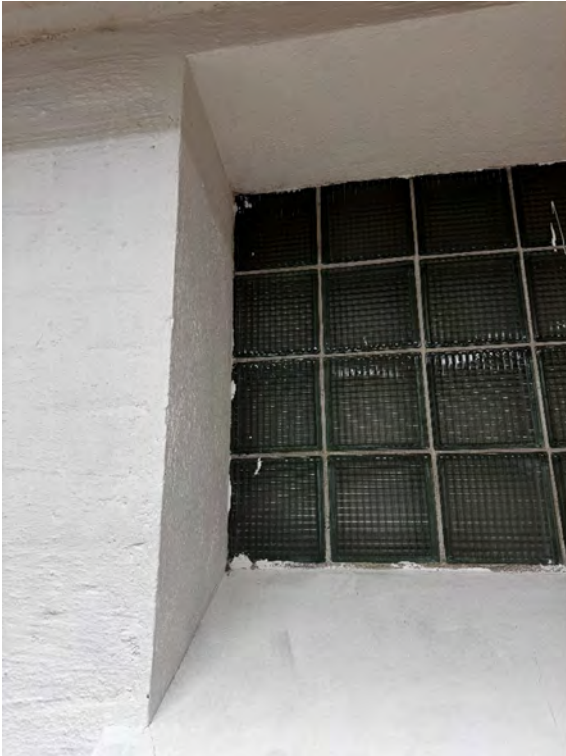
Kuva 12: Lasitiilet poistetaan.
