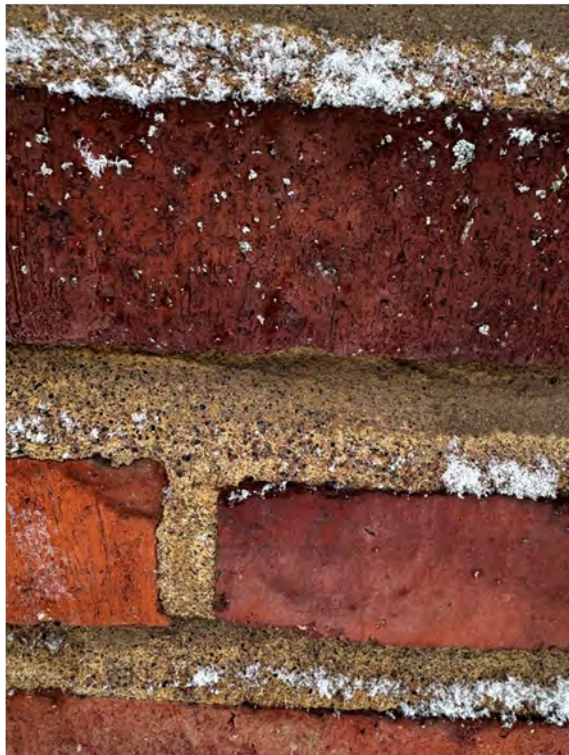
Kuva 19: Muuraussaumoja oli korjattu aiemmassa vaiheessa.
