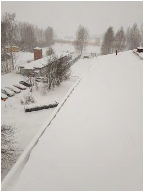
Kuva 35: Lumiesteiden määrä oli puutteellinen.
