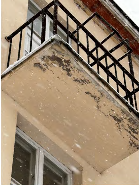
Kuva 21: Parvekelaatan vaurioita.
