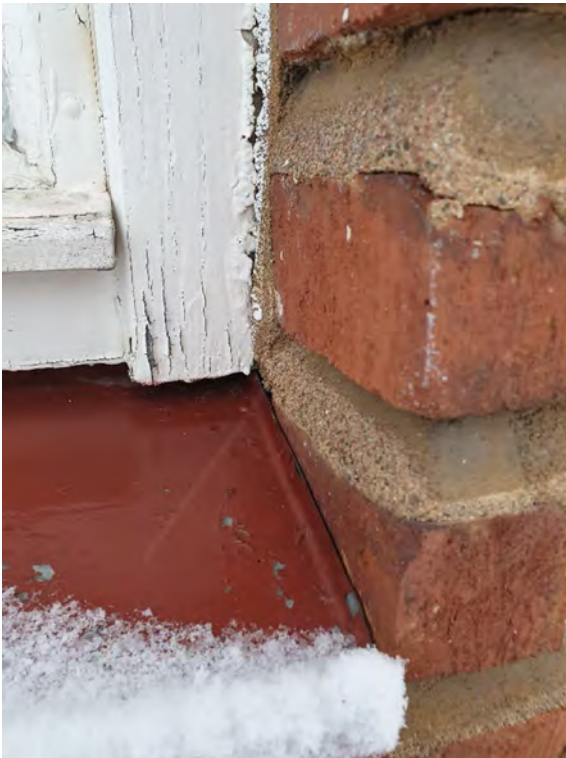
Kuva 31: Vesipellit ja kallistukset olivat hyvässä kunnossa
