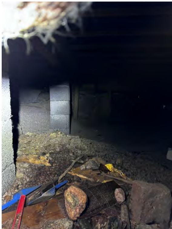
Kuva 11: Alapohjan harkkoperustuksia.
