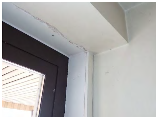
Kuva 19. Ovi liittymä seinärakenteeseen
