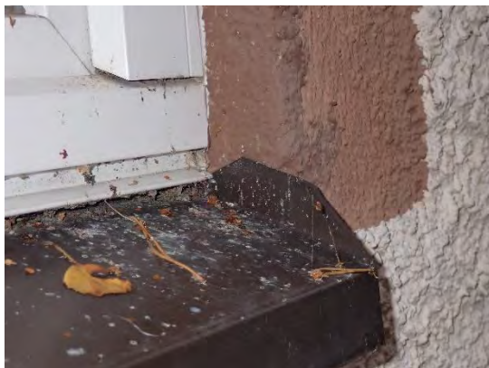
Kuva 16. Uuden ikkunan vesipeltiliitos
