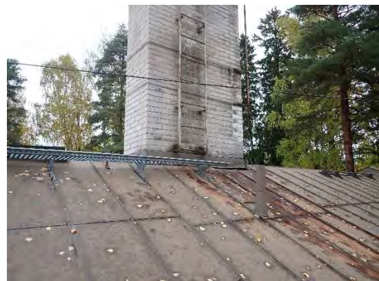
Kuva 28. Yleisnäkymä keittiö/asunto osan vesikatolle
