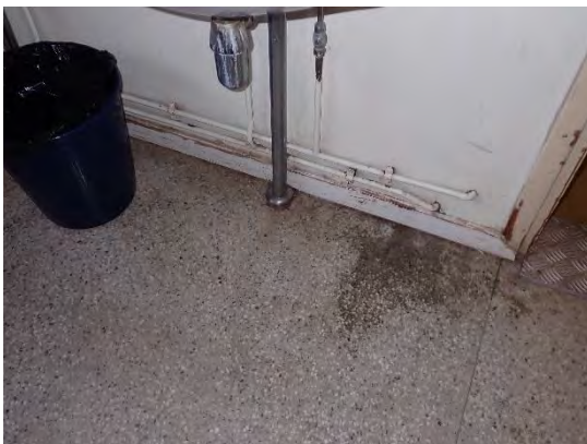
Kuva 11. Eteistilan alapohja, betonimosaikki pintalaatta
