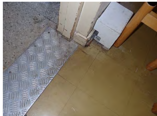
Kuva 12. Ala- ja välipohjarakenteen liittymänä ruokala/eteinen
