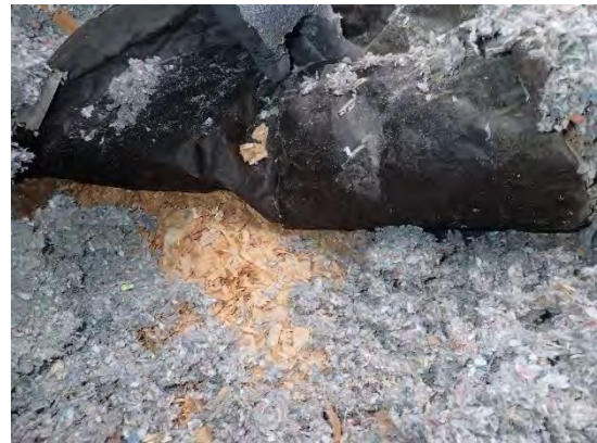
Kuva 38. Puhalluseristeen ja kutterilastueristeen välissä on bitumipaperi
