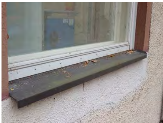
Kuva 20. Uuden ikkunan liittymä seinärakenteeseen
