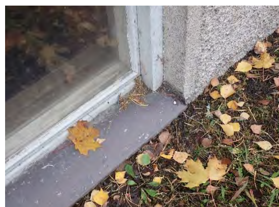
Kuva 17. Kellarin ikkunan liittymä perusmuuriin, lähellä maanpintaa
