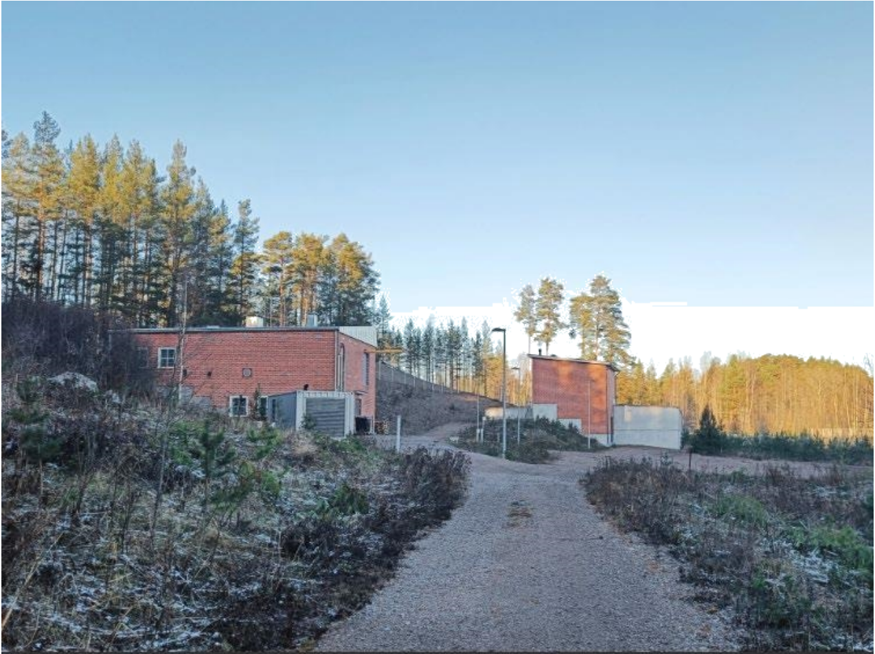
Vedenot- tamon kaksi rakennusta rakennettu vuonna 2015
