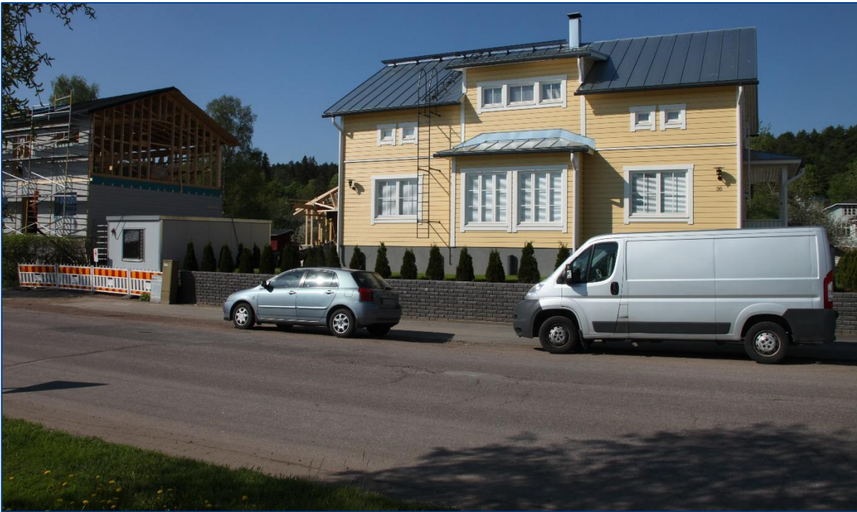
Kuva 5.1.1-1. Rantatien varrella meritulvien vaara-alueella olevia uusia sekä valmisteilla olevia asuinrakennuksia Loviisan keskustan tulvanperikereen taustalla. Uusissa rakennuksissa on otettu huomioon alimmat suositellut rakennuskorkeudet, mikä on nähtävissä sokkeleiden korkeudessa. (Kuva: FCG Suunnittelu ja tekniikka Oy pvm. 23.5.2014)
