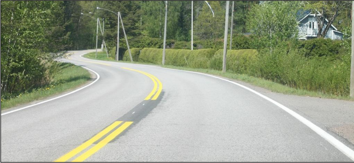
Kuva 5.3.1-1. Saaristotie katkeaa Määrilahden kohdalla 1/100a meritulvalla ( N_{2000} +2,22 ). (Kuva: FCG Suunnittelu ja tekniikka Oy, pvm. 23.5.2014).
