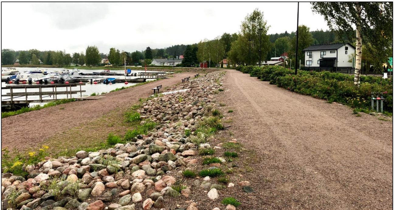
Kuva 2.3-1. Loviisan keskustan tulvapenger, näkymä Laivasillalta etelän suuntaan 9.9.2019
