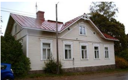
39. Asuinrakennus(1900- luvun vaihde?) ) suojeltu asemakaavassa. A-luokka, Kauppakatu 6.
