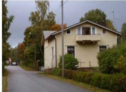
34. (1957 laajennus, onko runkona vanhempaa?) Kuva Laivanrakentajantien suunnalta, C-luokka.
