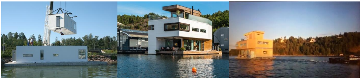
Kuvat 32,33,34. Referenssikuva kelluvan talon asentamista, valmis talo Ruotsissa ja kelluvan talon hinaus (Bluet oy)
