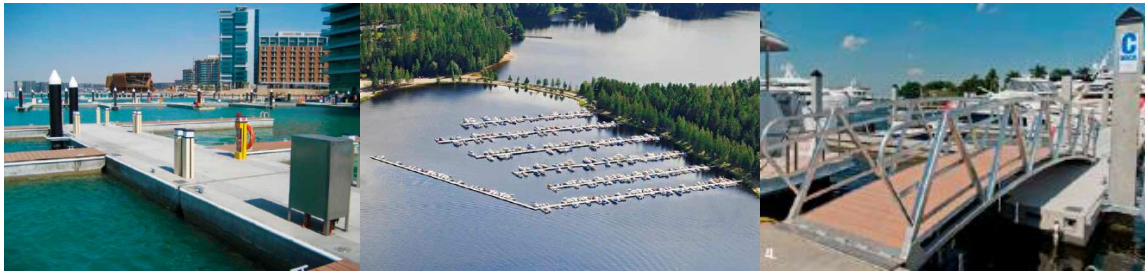
Kuvat 39,40,41. Satamarakenteiden kuvia ja New Port Imatra, Marinetek Finland
