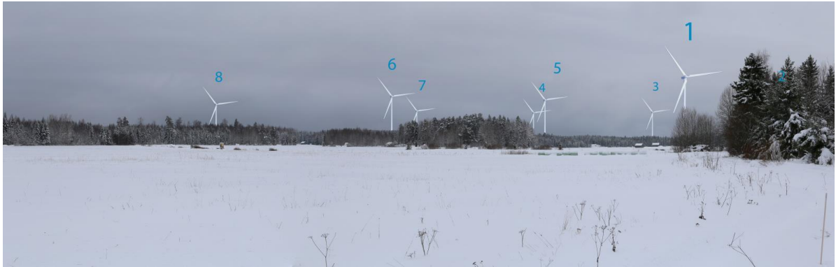
Kuva 10. Kuvasovite kaava-alueen pohjoispuoliselta peltoalueelta Ömossantieltä. Pihapiiri sijoittuu välittömästi kuvan oikealle puolelle. Etäisyys lähimpään tuulivoimalaan 1,6 kilometriä. Kuvasovite suuremmassa koossa kaavaselostuksen liitteessä 2.
