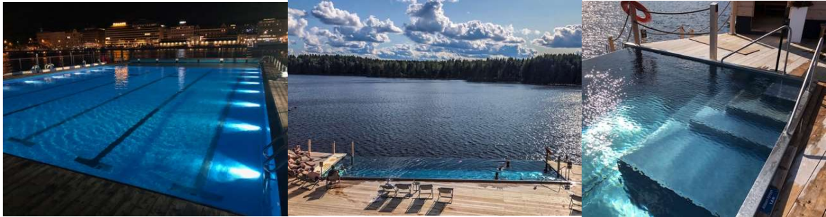
Kuva 24, 25, 26. Proomuallas ja maalle toteutettu teräsallas, infinity pool (Bluet Oy)
