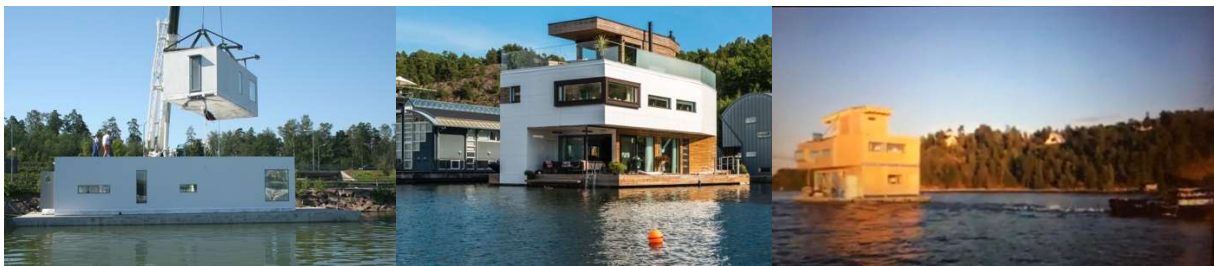
Kuvat 32,33,34. Referenssikuva kelluvan talon asentamista, valmis talo Ruotsissa ja kelluvan talon hinaus (Bluet oy)
