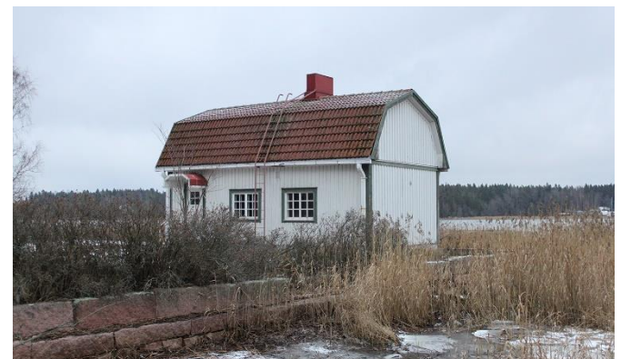
Sauna- ja talousrakennus. Etualalla rakennettua rantapengertä.
