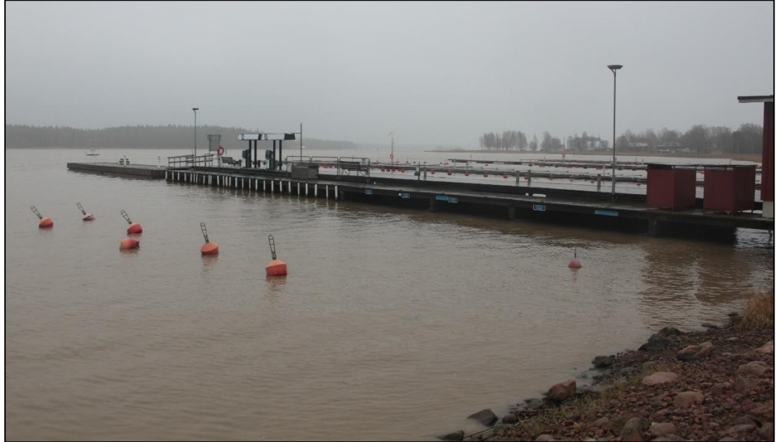
Kuva 6. Nykyisen Laivasillan päälaiturin pohjoisen puoleinen sivu. Etualalla kiinteä laituri ja taustalla sen jatkeena kelluva ponttonilaituri.
