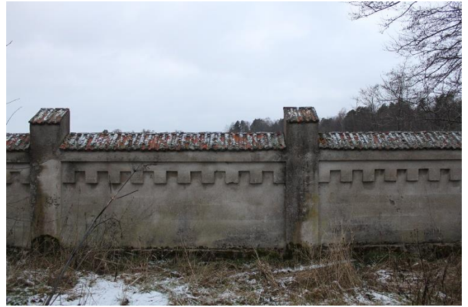
Kiinteistöä reunustavaa aita.
