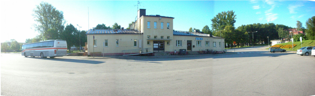
Kuva 4: Linja-autoaseman piha nykytilassa
