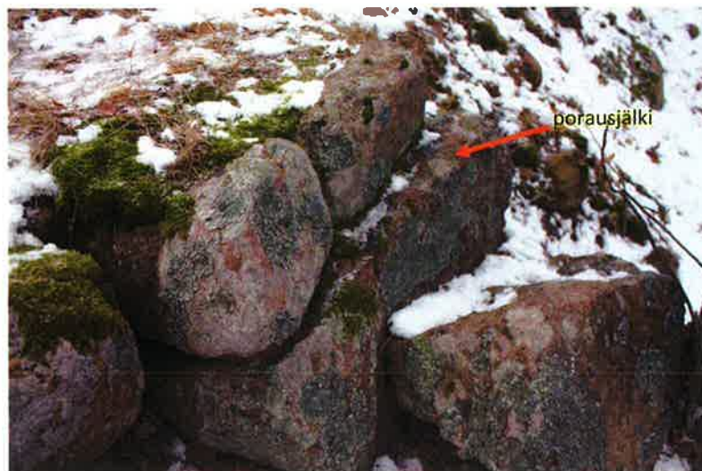
AKDG5145:14 Yksityiskohta lounaissivun tukimuurin kiveyksestä. Pohjoisempi osa. Keskimmäisessä kivessä erottuu pitkittäinen porausjälki. Luoteesta. Kuva Katja Vuoristo.
