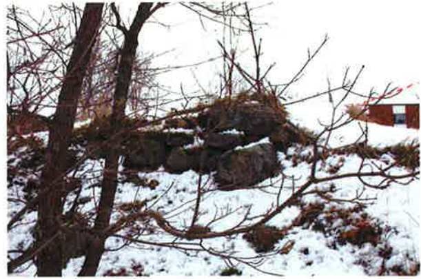
AKDG5145:15 Vallin lounais- eli ulkosivun puolustusmuuria oli säilynyt muutamassa kohdassa pari kiverrosta. Eteläisempi osa. Lännestä. Kuva Katja Vuoristo.
