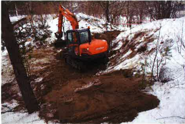
AKDG5145:23 Koeojaa täytetään. Pohjoisesta.
